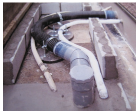
ガス管、水道管、雑排水配管処置 【フレキシブル型】 余長を持たせ地震の揺れによる動きに対応
