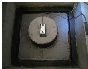
原点復帰機構 (オプション) 建屋基礎に2箇所設置
