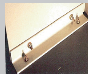
● 耐震工事施工例 (床面)
