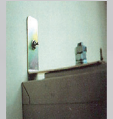
● 耐震工事施工例 (壁面)
