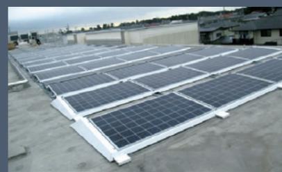
3 太陽光モジュールを設置し、配線接続後、ベース外周にカバーを取り付けます。
