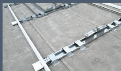
1 施工図を参照し隅出しを行った後、ベースレールを連結します。
